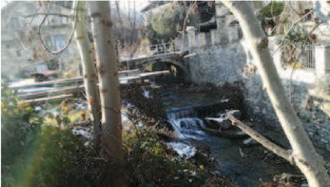
Figura 4: ponticello ad arco in pietrame.
