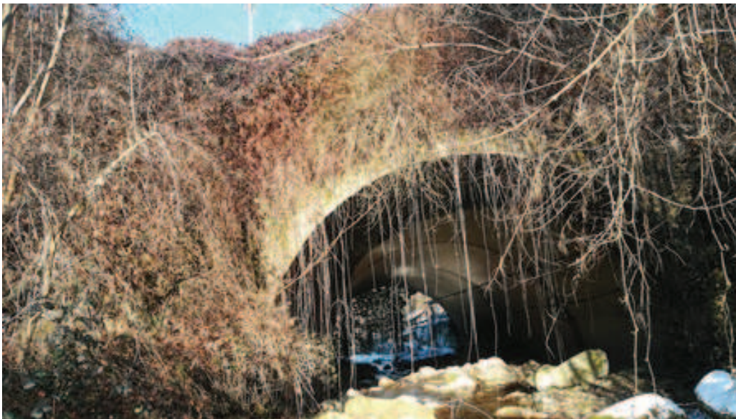
Figura 3: attraversamento della strada Provinciale.
