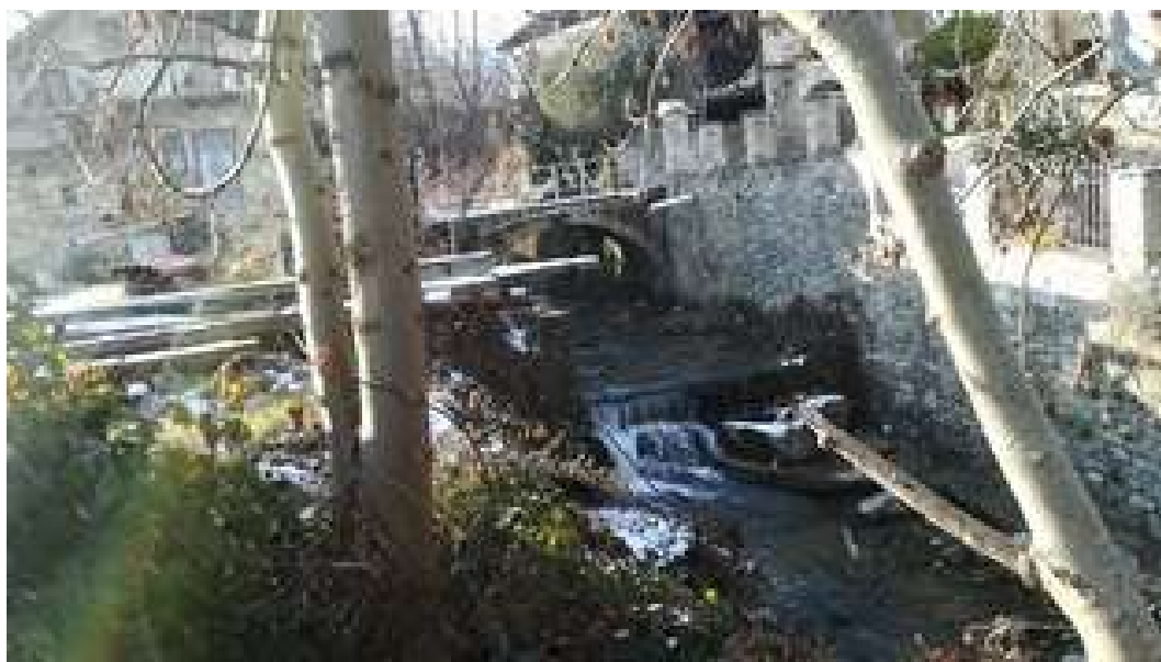
Figura 4: ponticello ad arco in pietrame.
