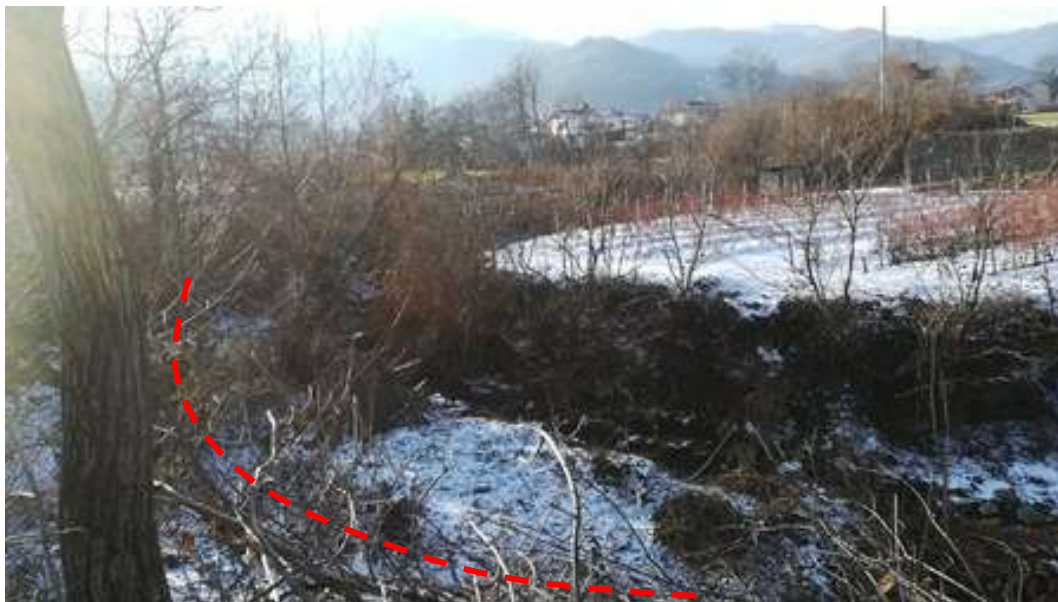
Figura 10: fenomeni di erosione spondale in corrispondenza della sezione RS3.
