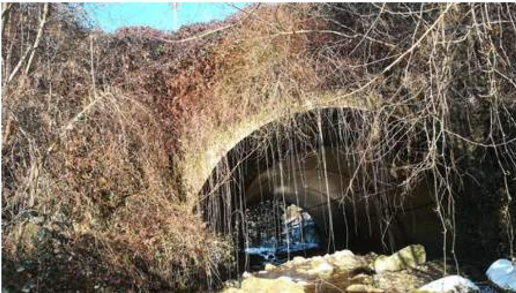
Figura 3: attraversamento della strada Provinciale.
