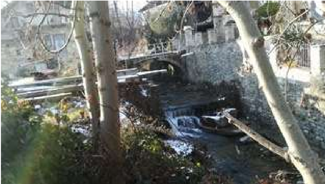
Figura 4: ponticello ad arco in pietrame.
