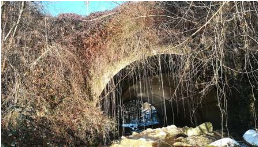
Figura 3: attraversamento della strada Provinciale.
